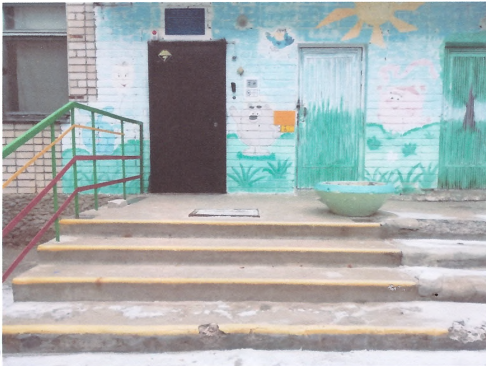
Фото №6 лестница наружная
