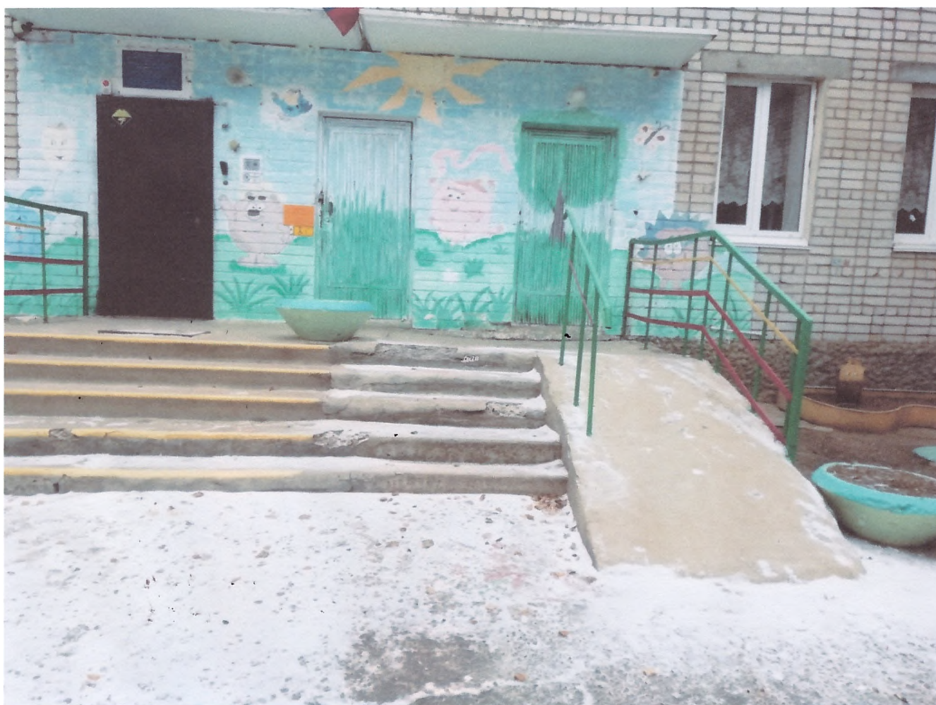
Фото №5 Вход в здание (пандус наружный)
