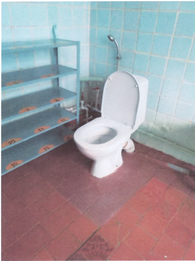
Фото №16 Туалетная комната
