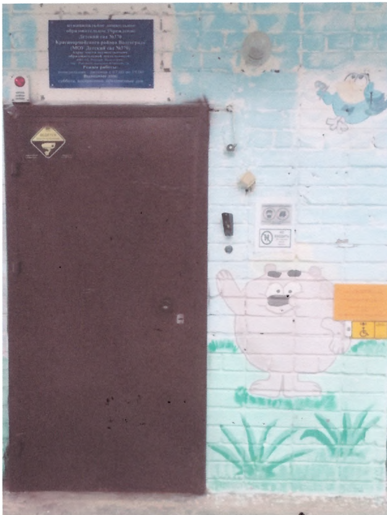
Фото №7 Дверь (входная)
